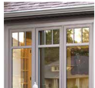
Vue extérieure d'une grille de simlicarreaux.
